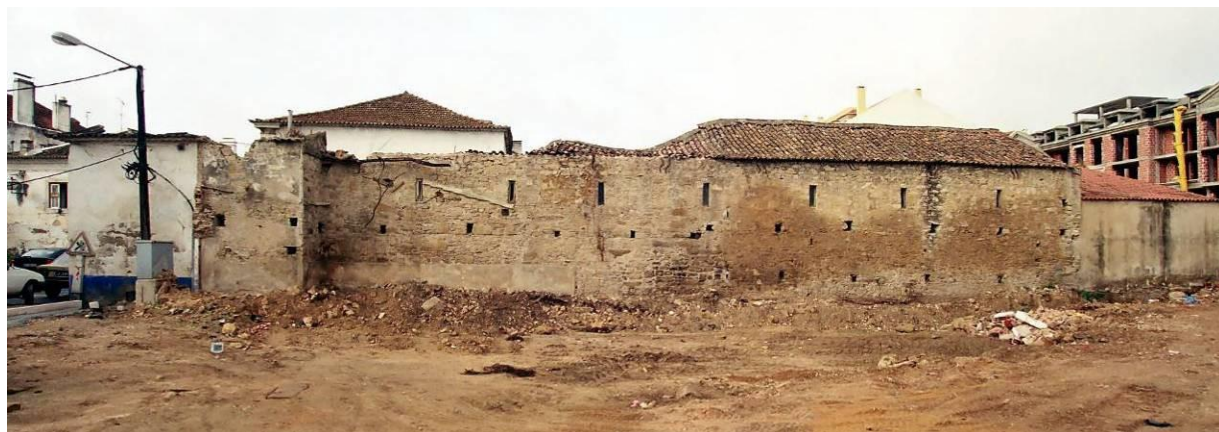
Fig. 37 – Fachada nascente do stand , após a demolição do edifício contíguo (note-se o abaixamento da cota do terreno).
