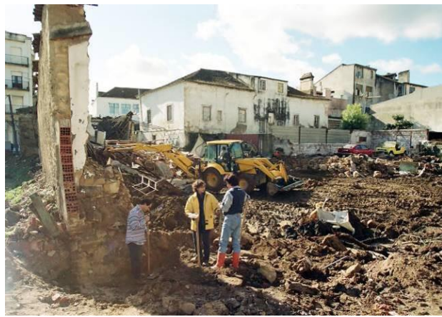
Figs. 62 a 65 – Abertura da Sondagem 1.
