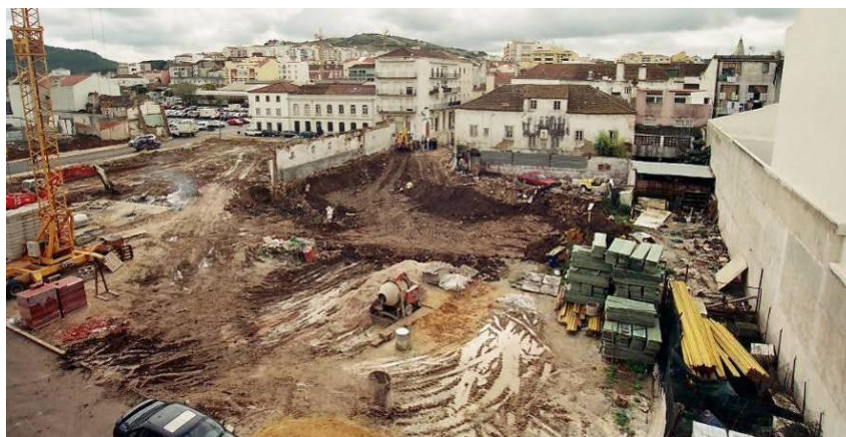
Fig. 52 – Vista do local, aquando do início dos trabalhos.
