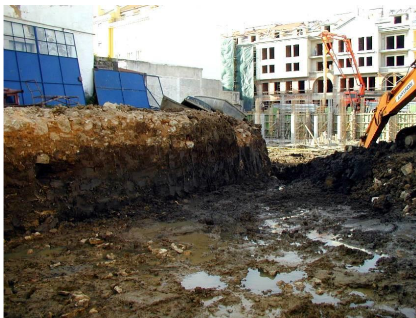
Fig. 134 – Limpeza do terreno envolvente, para escavação da Estrutura C.
