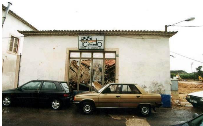
Fig. 1 – Fachada Sul do antigo stand Comauto.
