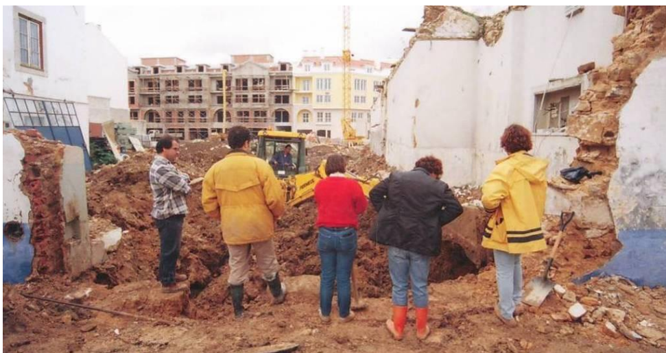
Fig. 107 – Em segundo plano, o grande volume de terras colocado no local.
