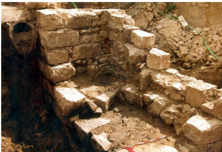
Figs. 151 a 153 – Aspectos da estrutura arquitectónica.
