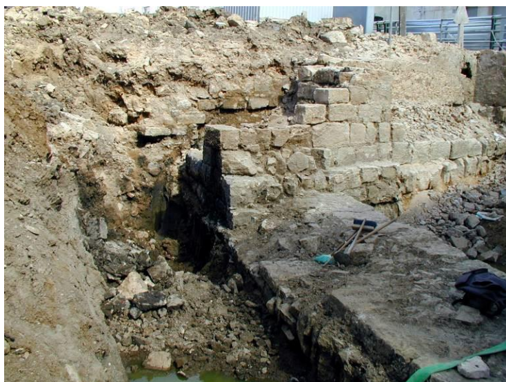
Figs. 139 a 141 – Picagem do reboco que cobria a muralha (Estrutura B) e limpeza geral (Estruturas B e C).
