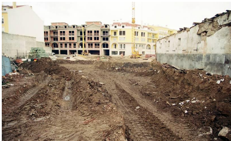
Fig. 47 – Interior do stand demolido, restando apenas a parede nascente.
