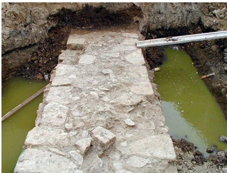
Figs. 154 a 156 – Pormenores da construção.
