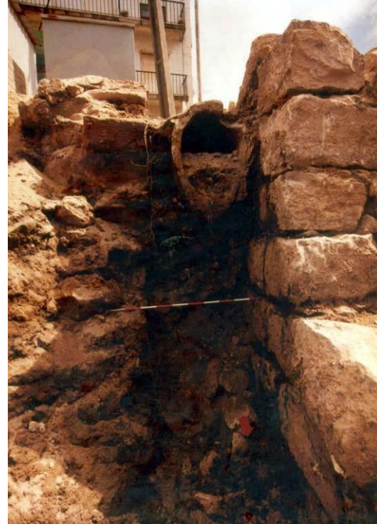
Figs. 142 e 143 – Demolição da fachada do antigo stand : a dupla parede, separada pela conduta.
