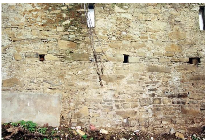
Figs. 41 e 42 – Pormenores da construção.
