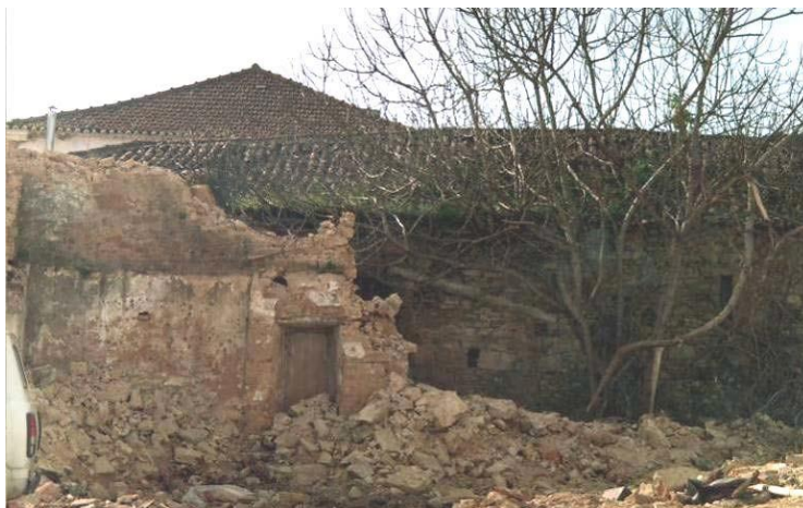
Fig. 33 – Fachada nascente do stand , com vestígios do edifício contíguo.
