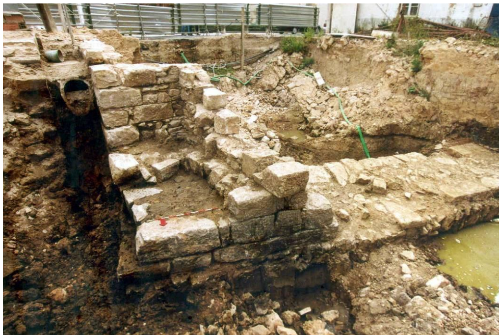
Figs. 147 e 148 – A muralha (Estruturas B e C), vendo-se, ao fundo, a zona desmoronada onde se encontrava a Estrutura A.
