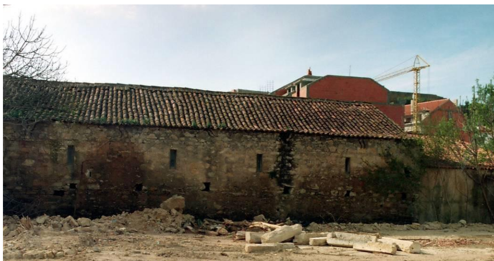
Fig. 32 – Fachada nascente do stand , antes do início das demolições.
