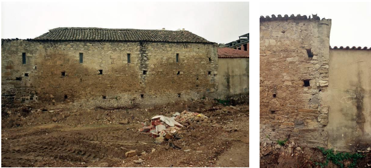
Figs. 54 e 55 – Fachada do stand , antes da demolição do anexo (à direita).
