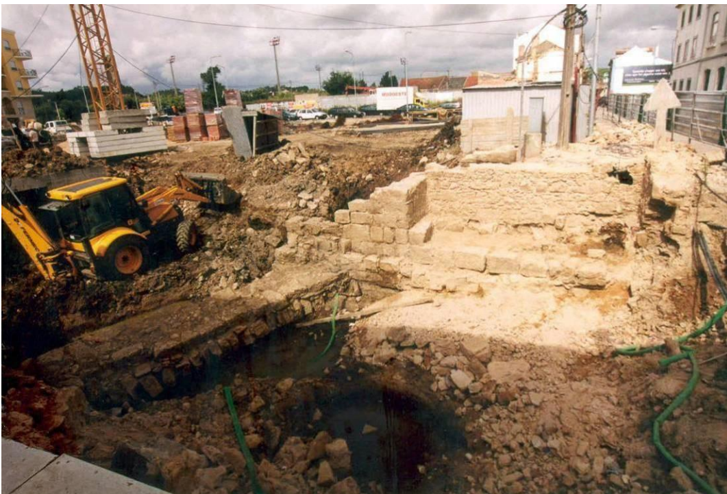
Figs. 145 e 146 – As estruturas já escavadas.
